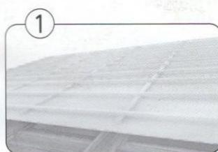
Кровельная супердиффузионная мембрана монтируется непосредственно на стропила поверх утеплителя и закрепляется контрабрусом с образованием вентиляционных каналов.
